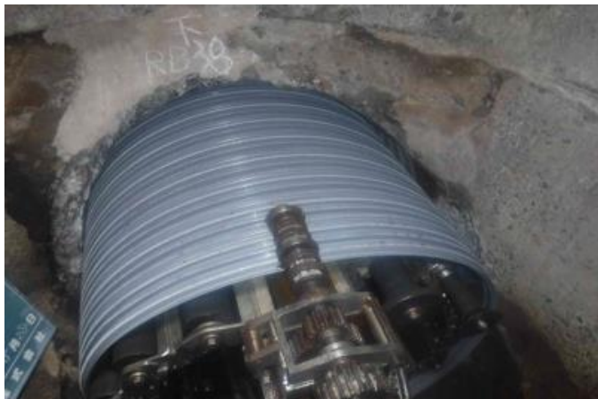
下水道管リニューアル施工状況
