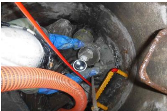
モルタル注入施工状況
