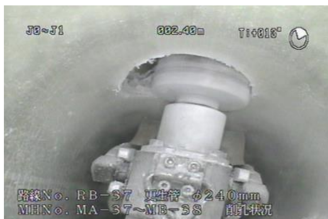
取付管削孔状況
