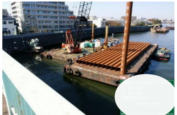
護岸防護杭打込み状況
