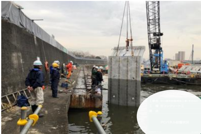
笠コンクリートパネル設置状況
