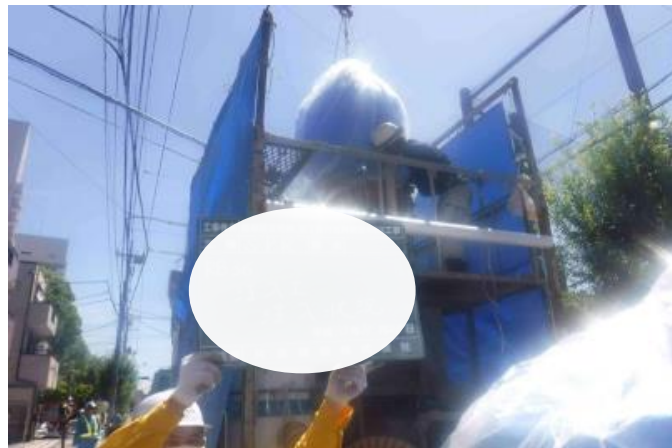
モルタル注入施工状況
