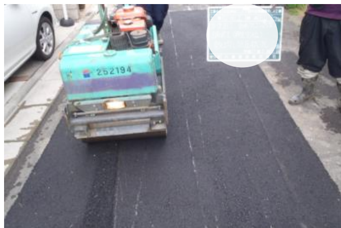
仮舗装転圧状況
