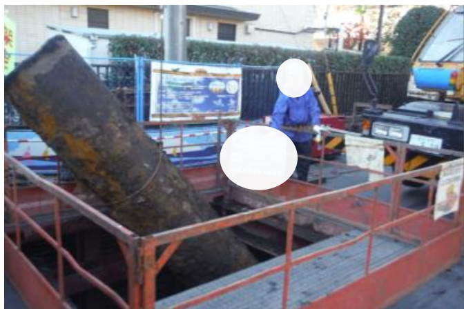
既設水道管撤去
