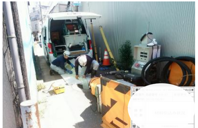
材料挿入状況
