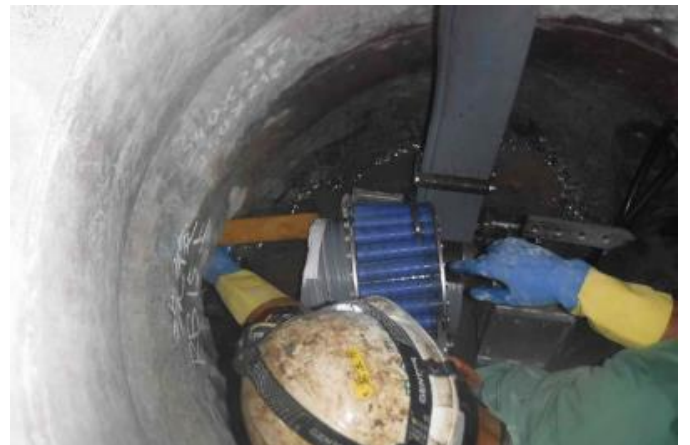
人孔（マンホール）内施工状況
