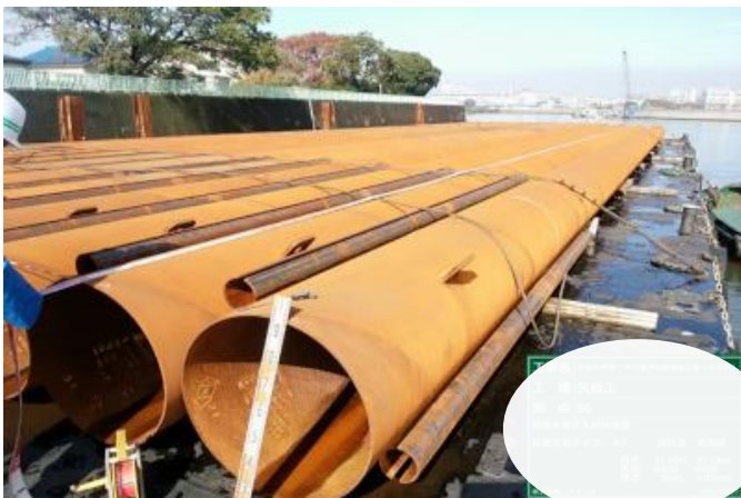
護岸防護杭運搬状況（鋼管杭）
