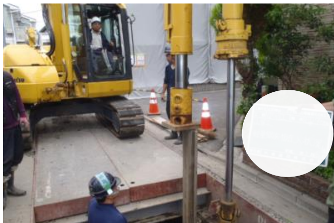
土留圧入状況
