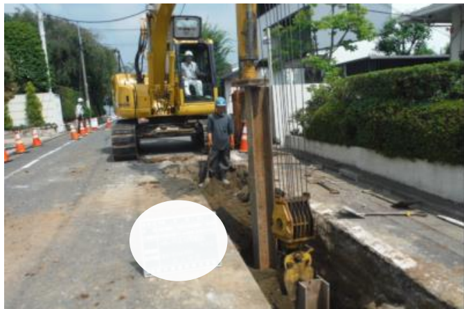
土留め杭打ち状況
