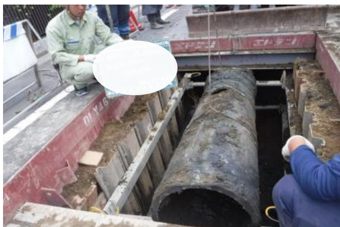
既設下水道管撤去状況
