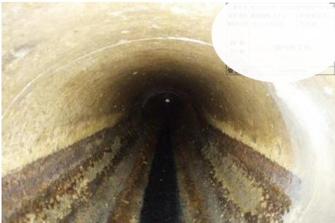
既設下水道管内状況
