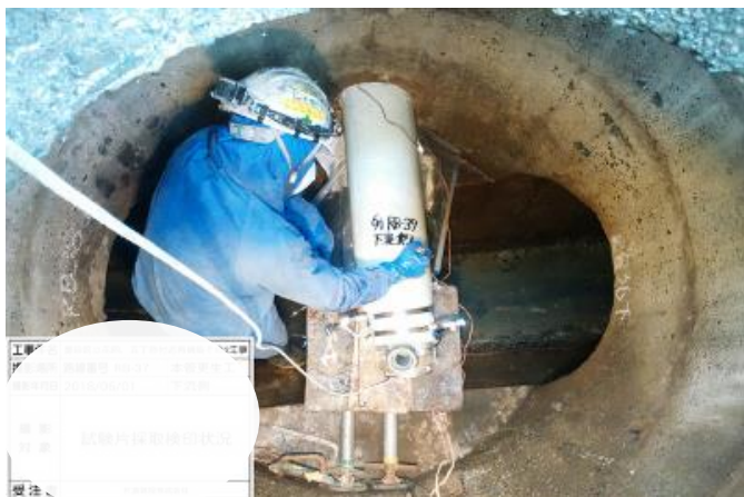
下水道管リニューアル施工状況
