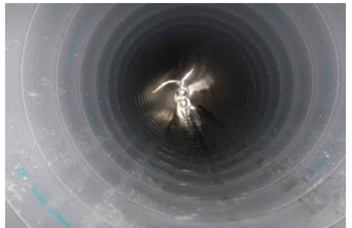
リニューアルした下水道管内状況
