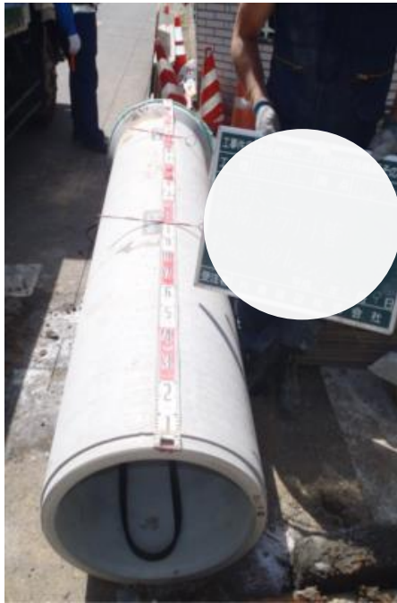
新設下水道管 (鉄筋コンクリート管)
