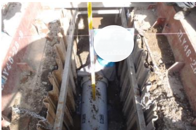
新設下水道管布設状況
