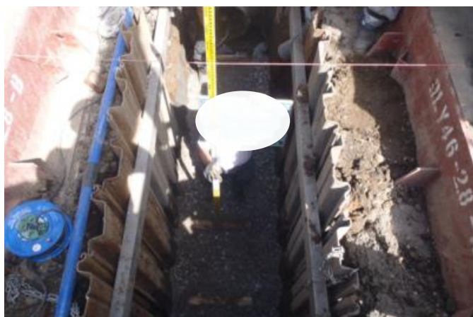
既設下水道管撤去、床付け状況
