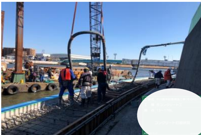
笠コンクリート打設状況
