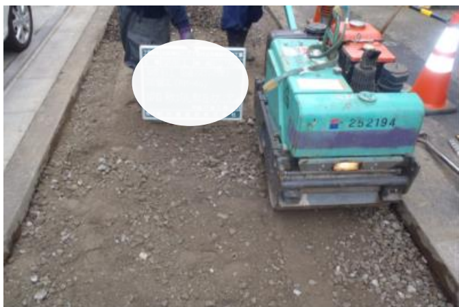
基礎碎石敷均し・転圧状況
