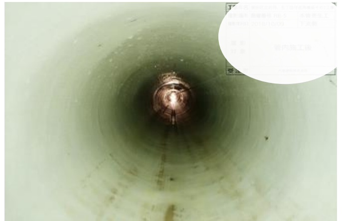
リニューアルした下水道管内状況
