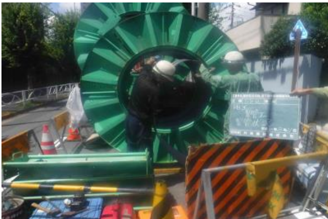
既設下水道管リニューアル施工状況
