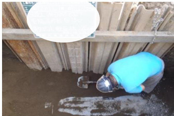
埋め戻し状況
