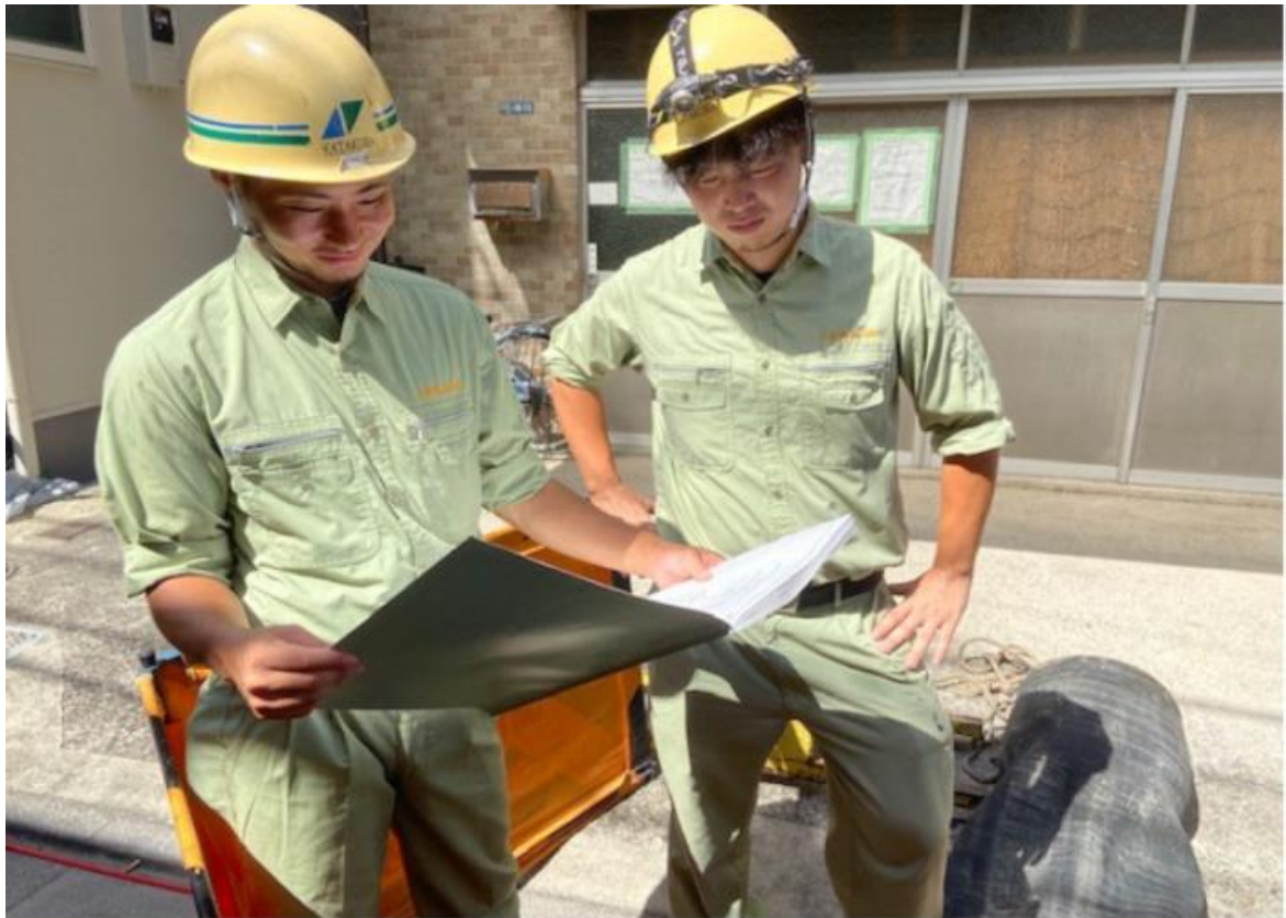
図面を確認し出来高、品質管理を行います。
