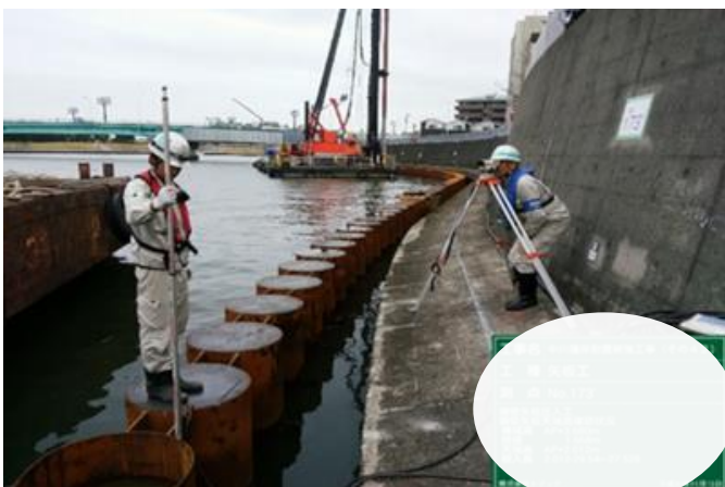
護岸防護杭打込み状況
