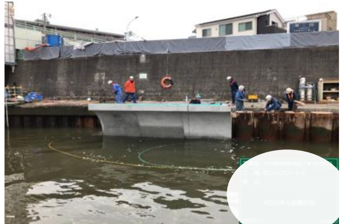
笠コンクリートパネル設置状況
