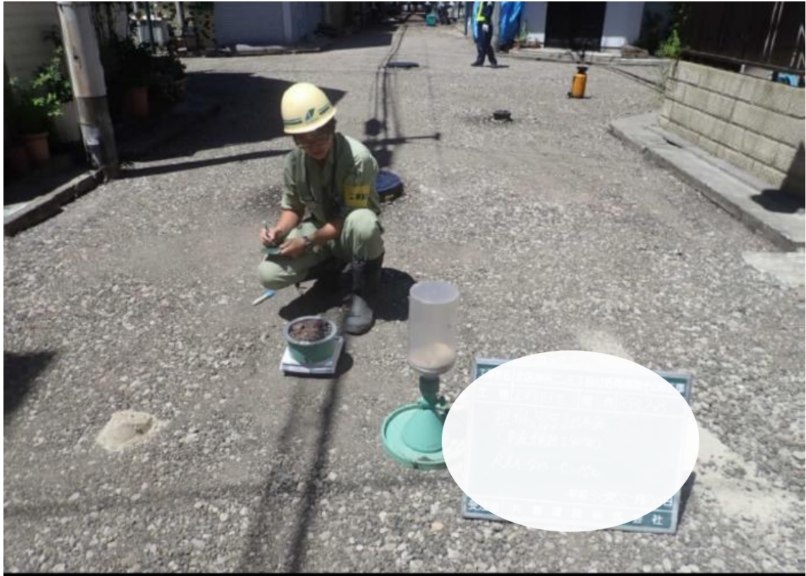
道路舗装施工時に品質管理を行います。（路盤密度試験（強度の確認））
