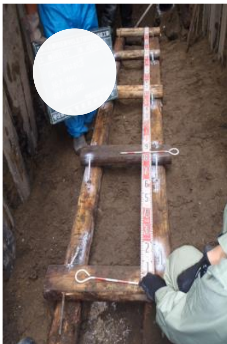
基礎 枕木設置状況
