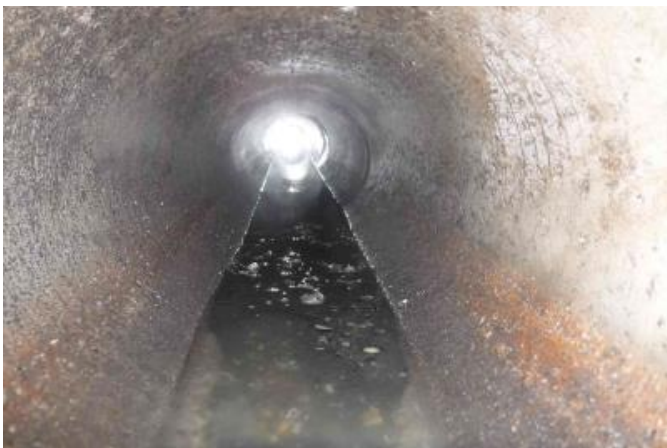
既設下水道管内状況
