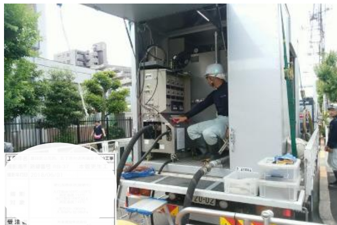
下水道管リニューアル拡張・硬化状況
