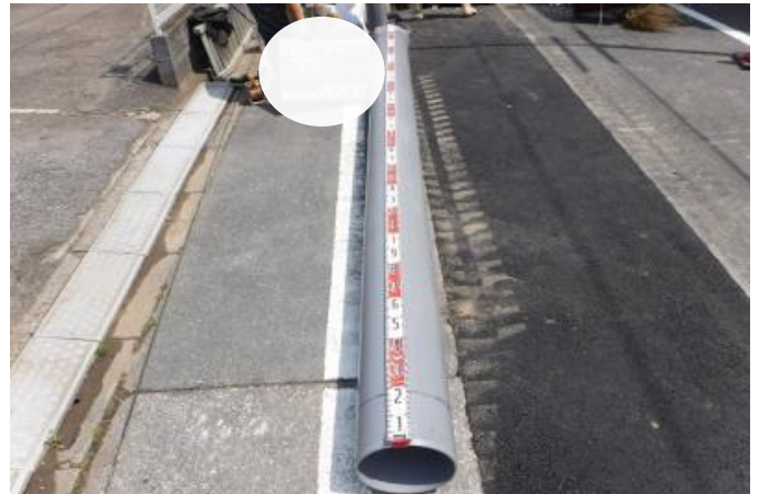
新設下水道管（硬質塩化ビニル管）
