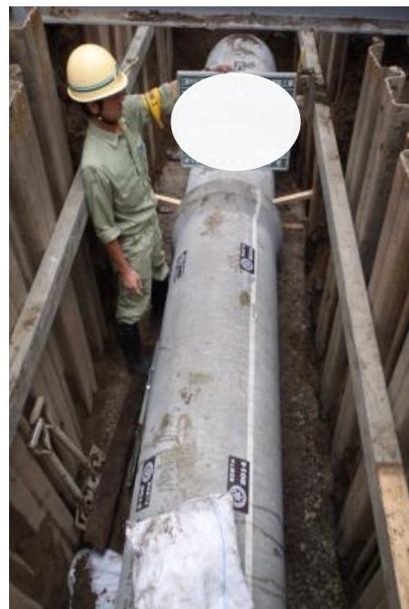
新設下水道管布設状況
