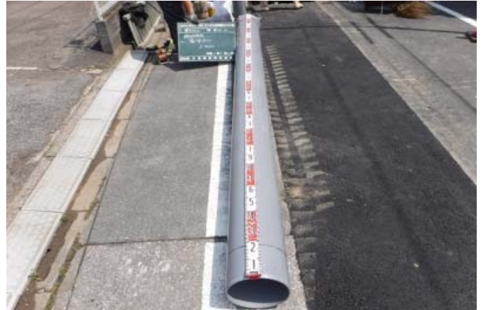
新設下水道管（硬質塩化ビニル管）
