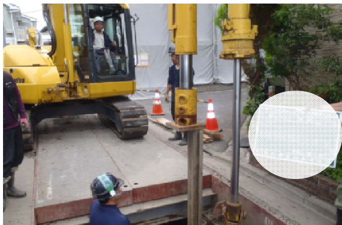
土留圧入状況
