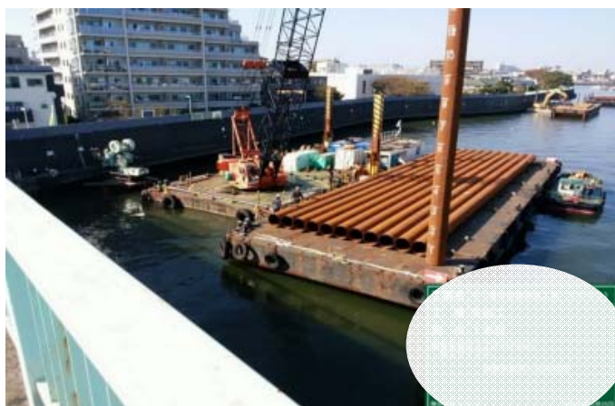
護岸防護杭打込み状況
