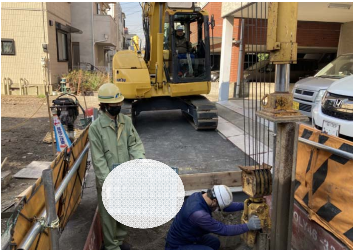
計画、作業手順通り、安全に施工しているか管理を行います。
