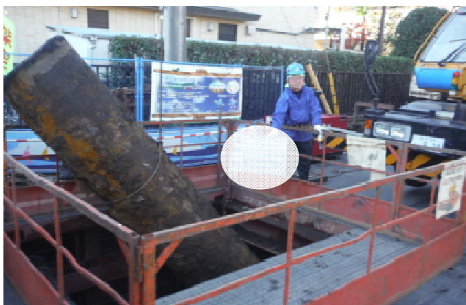
既設水道管撤去
