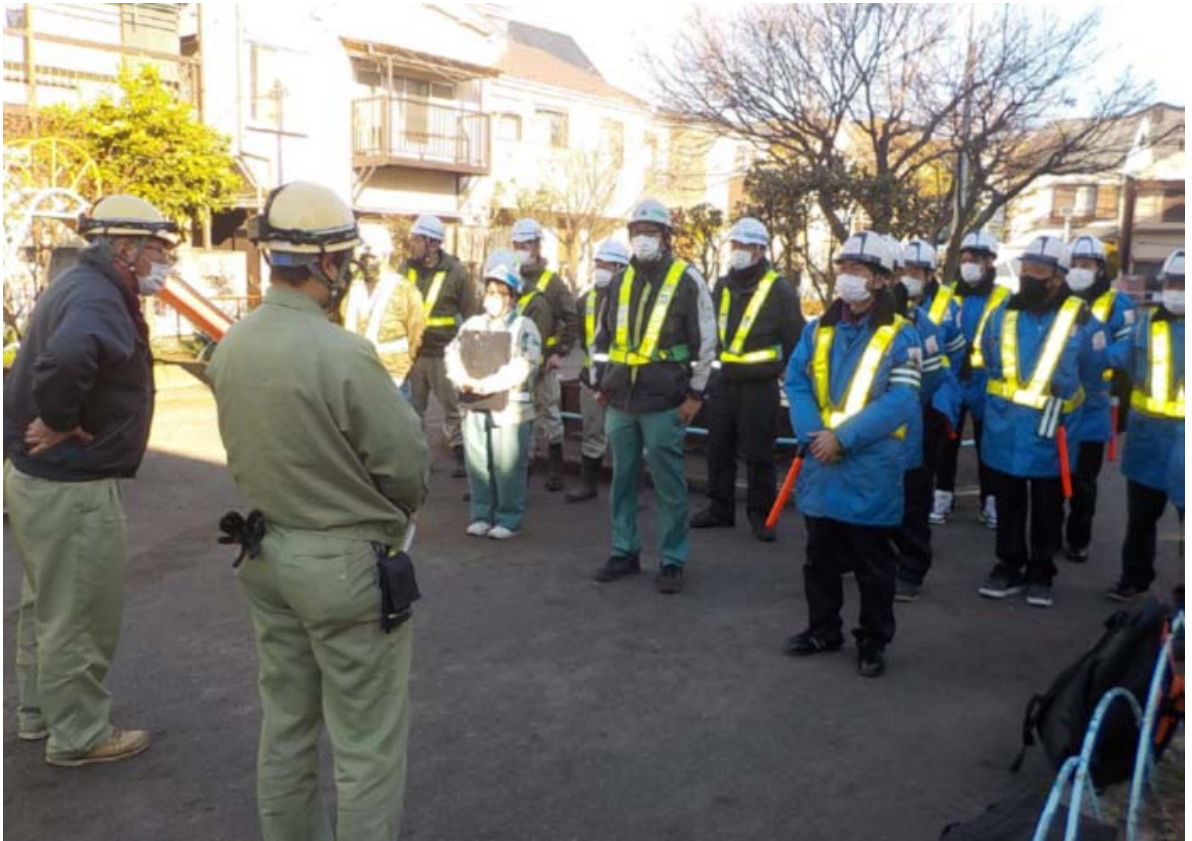
朝礼（作業内容、安全対策を確認します。）
