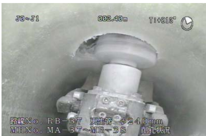
取付管削孔状況
