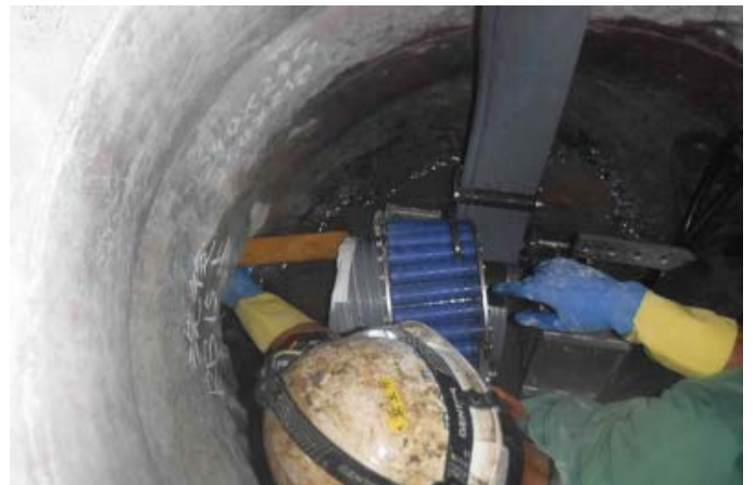
人孔（マンホール）内施工状況
