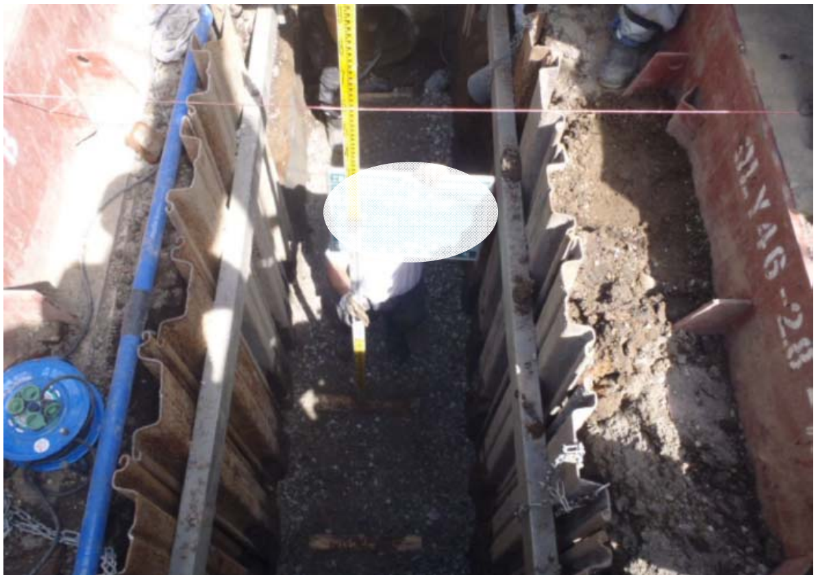
出来高管理を行います。（掘削深さの確認）
