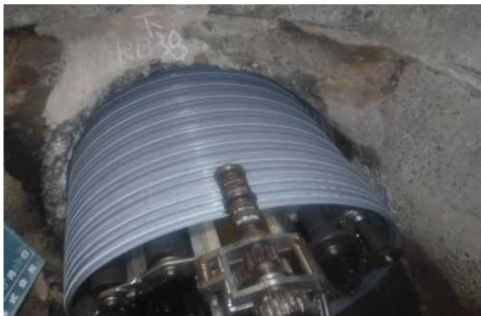
下水道管リニューアル施工状況
