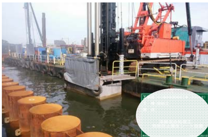
地盤改良施工状況
