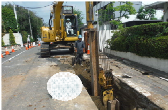
土留め杭打ち状況
