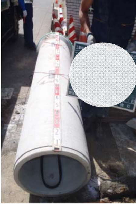
新設下水道管 (鉄筋コンクリート管)
