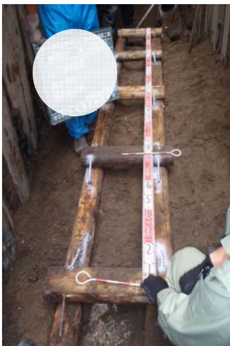
基礎 枕木設置状況
