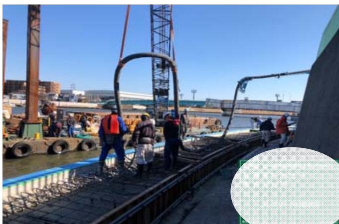
笠コンクリート打設状況
