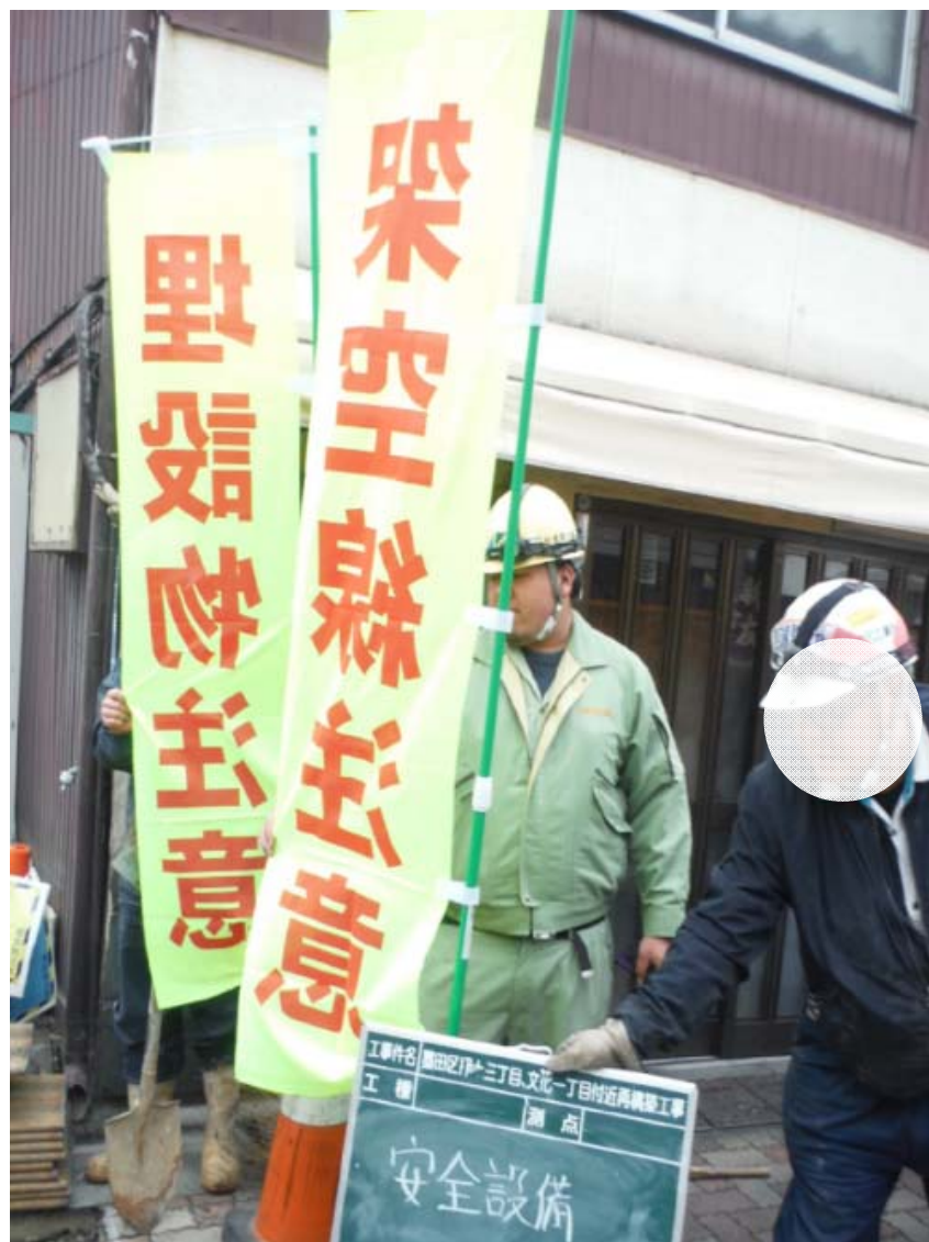
協力業者と架空線の位置を確認し、注意喚起を行います。
