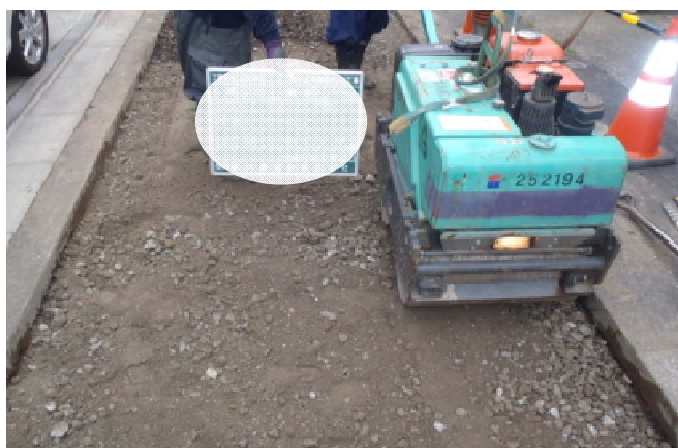
基礎碎石敷均し・転圧状況
