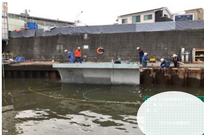
笠コンクリートパネル設置状況
