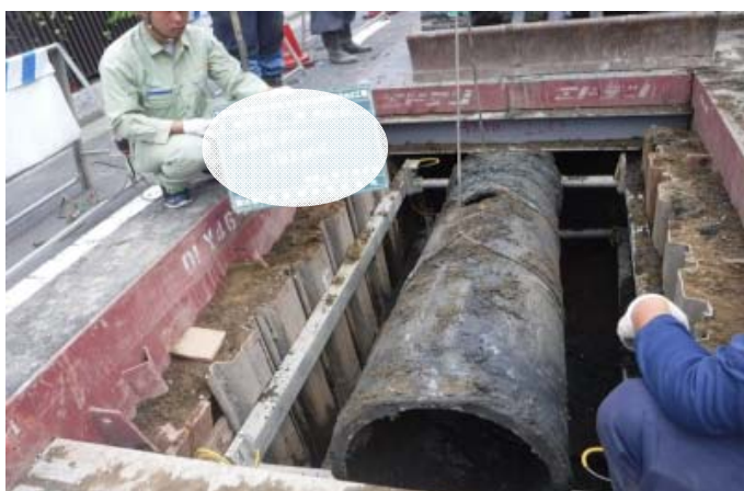
既設下水道管撤去状況
