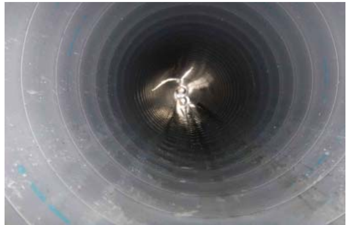
リニューアルした下水道管内状況
