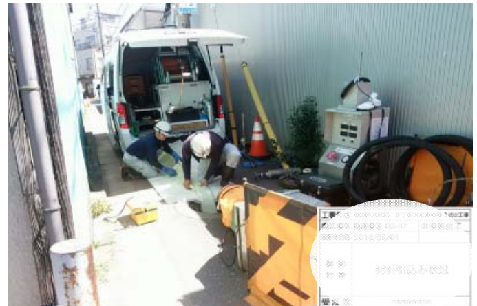
材料挿入状況
