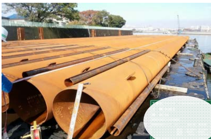
護岸防護杭運搬状況（鋼管杭）
