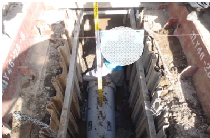
新設下水道管布設状況
