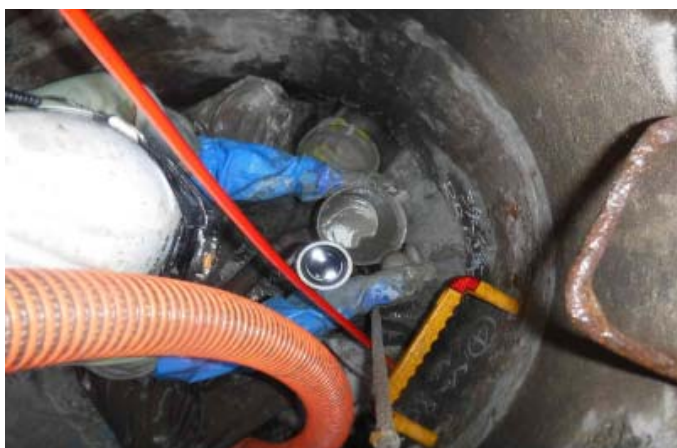
モルタル注入施工状況
