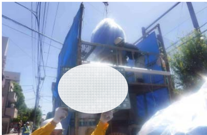
モルタル注入施工状況
