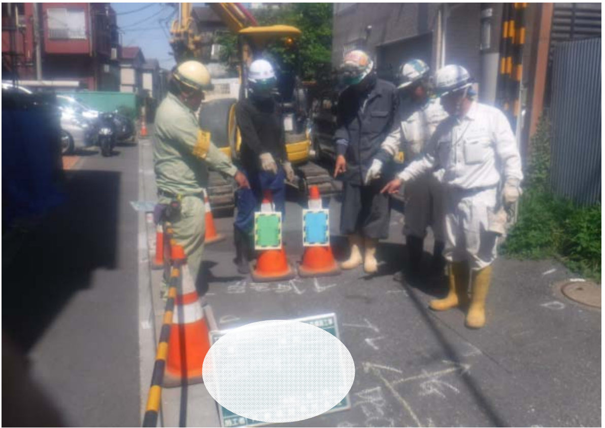
協力業者と地下埋設物の位置を確認し、注意喚起を行います。
