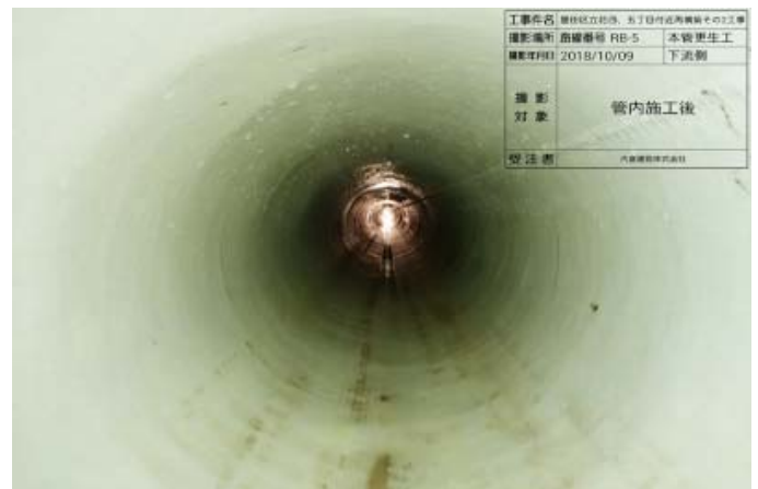
リニューアルした下水道管内状況
