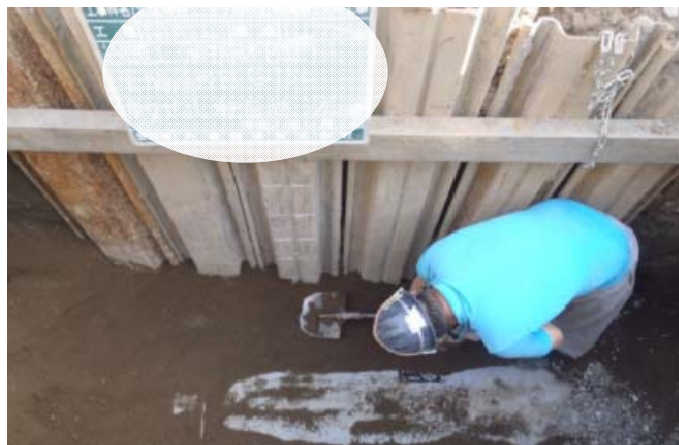
埋め戻し状況
