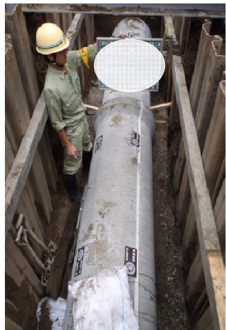
新設下水道管布設状況
