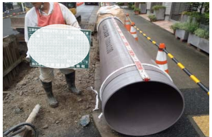
新設下水道管（強化プラスチック複合管）
