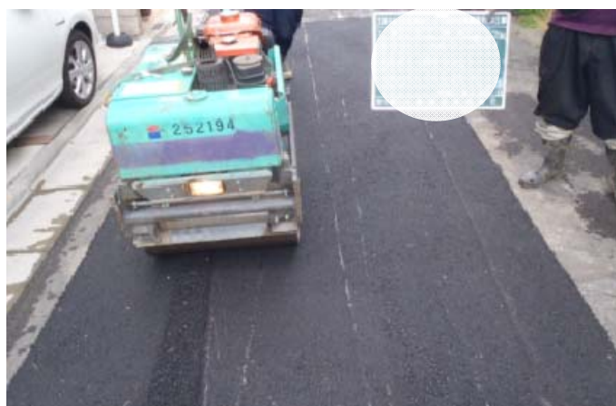
仮舗装転圧状況
