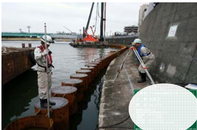
護岸防護杭打込み状況
