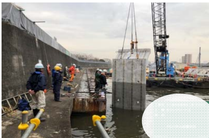
笠コンクリートパネル設置状況
