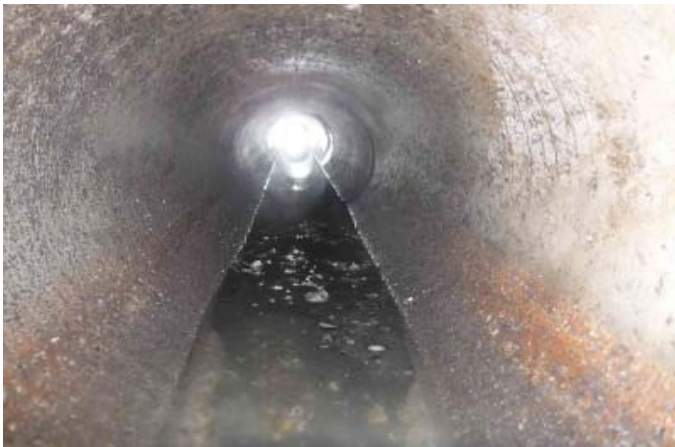
既設下水道管内状況
