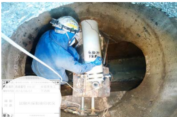
下水道管リニューアル施工状況
