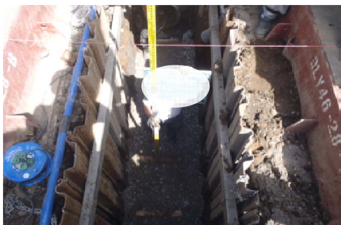
既設下水道管撤去、床付け状況
