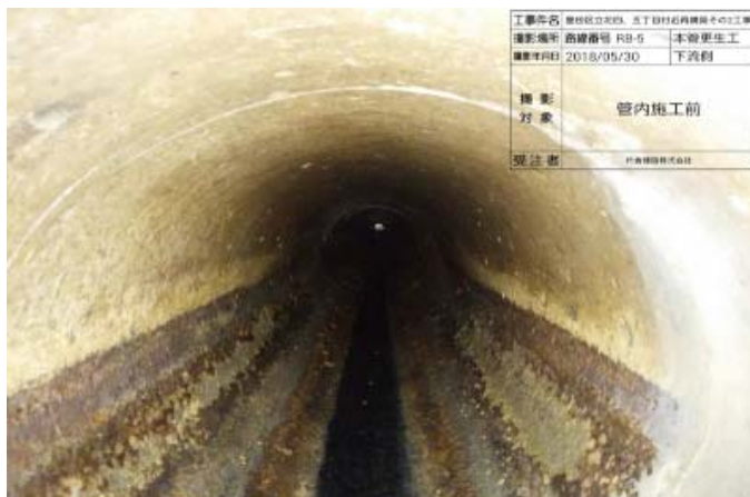
既設下水道管内状況
